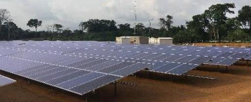
Sistema aislado de energía que lo constituye una planta fotovoltaica de 500kw y un sistema de almacenamiento de algo más de 1MW constituido por baterías de últimas tecnologías.
